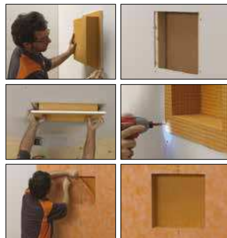
Construcción en cartón yeso
