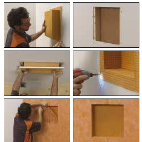
Instalación con paneles de cartón yeso:
