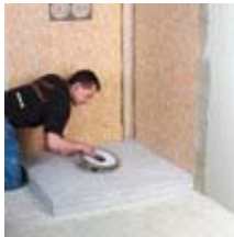
5 Instalar el elemento de desagüe
