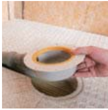
3 Instalar el bote de salida
