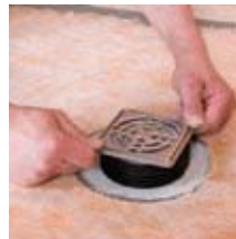
9 Nivelar la rejilla de acero inoxidable con salida durante la instalación
