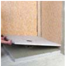
4 Colocar el panel de pendiente
