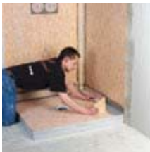
7 Colocar la impermeabilización
