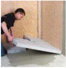
1 y 2 Colocar el panel de compensación
