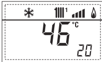
21. Visualización termostato de seguridad ZONA MIX (entrada S1) respectivamente ON y OFF
