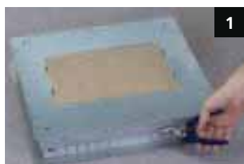
1 Recortar las entradas de canal
