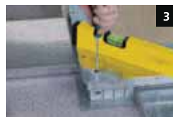
3 Nivelar con los tornillos
