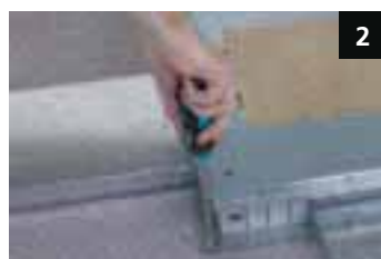
2 Introducir las canales y atornillar al suelo
