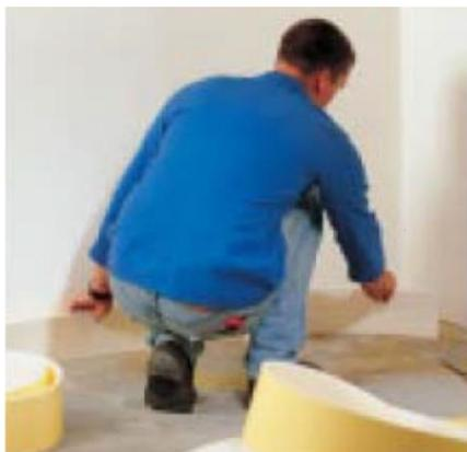
La banda perimetral se debe colocar en todo el perímetro de las estancias. Apoyándola provisionalmente sobre el tabique, para luego sujetarla con las placas de aislamiento. El zócalo se fijará a la pared por medio de grapas o utilizando un zócalo autoadhesivo, este a su vez, fija el film antihumedad. La banda perimetral se instalará teniendo en cuenta que la lámina de polietileno que lleva adherida (babero) debe quedar situada en la cara opuesta a la del contacto pared-banda perimetral.
