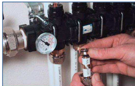
Colocar el conector y montar al colector
