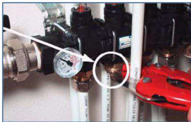
Cortar el tubo a la medida adecuada
