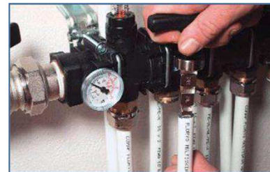
Calibrar / abocardar el tubo (tubo multicapa)
