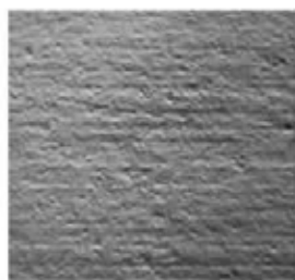
CSP 4 (Escarificado ligero)
