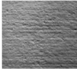
CSP 4 (Escarificado ligero)
