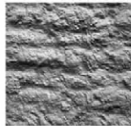
CSP 9 (Escarificado intenso)
