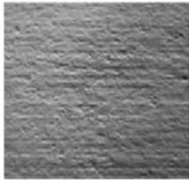
CSP 4 (Escarificado ligero)
