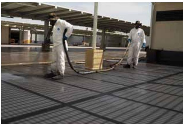
**TECNOCOAT P-2049** dispone de certificación DTA 5.2 19/2665, ETE 21/0942 y BBA 16/5340, con una vida útil de **25 años** para un espesor mínimo de 1,4 mm (grosor recomendado de 2 mm, consumo  $\pm 2,1$  kg/m<sup>2</sup>). Posee el certificado francés para cubiertas Avis Technique para el sistema completo.
