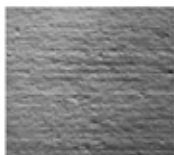
CSP 4 (Escarificado ligero)
