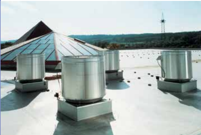
Ventiladores de cubierta para extracción de humo, serie BVD 710
