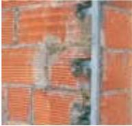
Aplicar con una paleta o llana inmediatamente después del amasado. Insertar el elemento a anclar y presionar bien para asegurar un buen anclaje.
