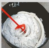
Amasar **weber.tec glass** con 5,5 – 6,5 litros de agua limpia por saco de 25 kg, manualmente o con un batidor eléctrico lento (500 rpm), hasta obtener una masa homogénea y exenta de grumos.
