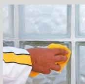
Armar el tabique mediante varillas de acero galvanizado de 6 mm de diámetro, sin que éstas entren en contacto con el vidrio.
