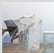
Aplicar la pasta sobre el bloque de vidrio. Colocar las piezas con crucetas, para obtener un ancho de junta regular.
