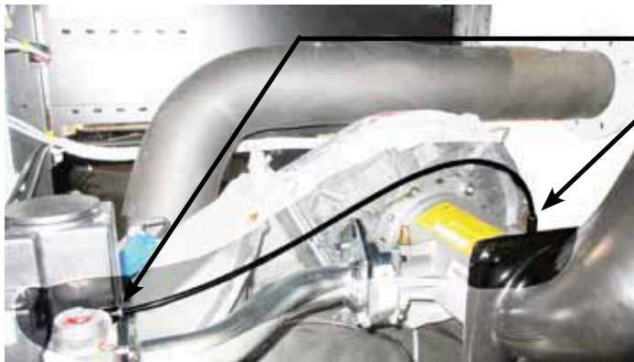
figura 40 - Ajuste válvula de gas
