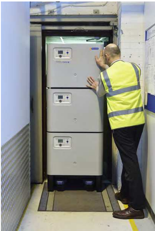
Figura 2.2 - Introducción de la caldera
