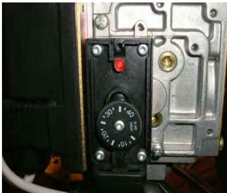
Figura 8.1.2 - Presostato de mínima presión de gas
