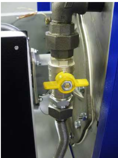
Figura 7.2.1 - Válvula de gas (foto modelos 100/120)
