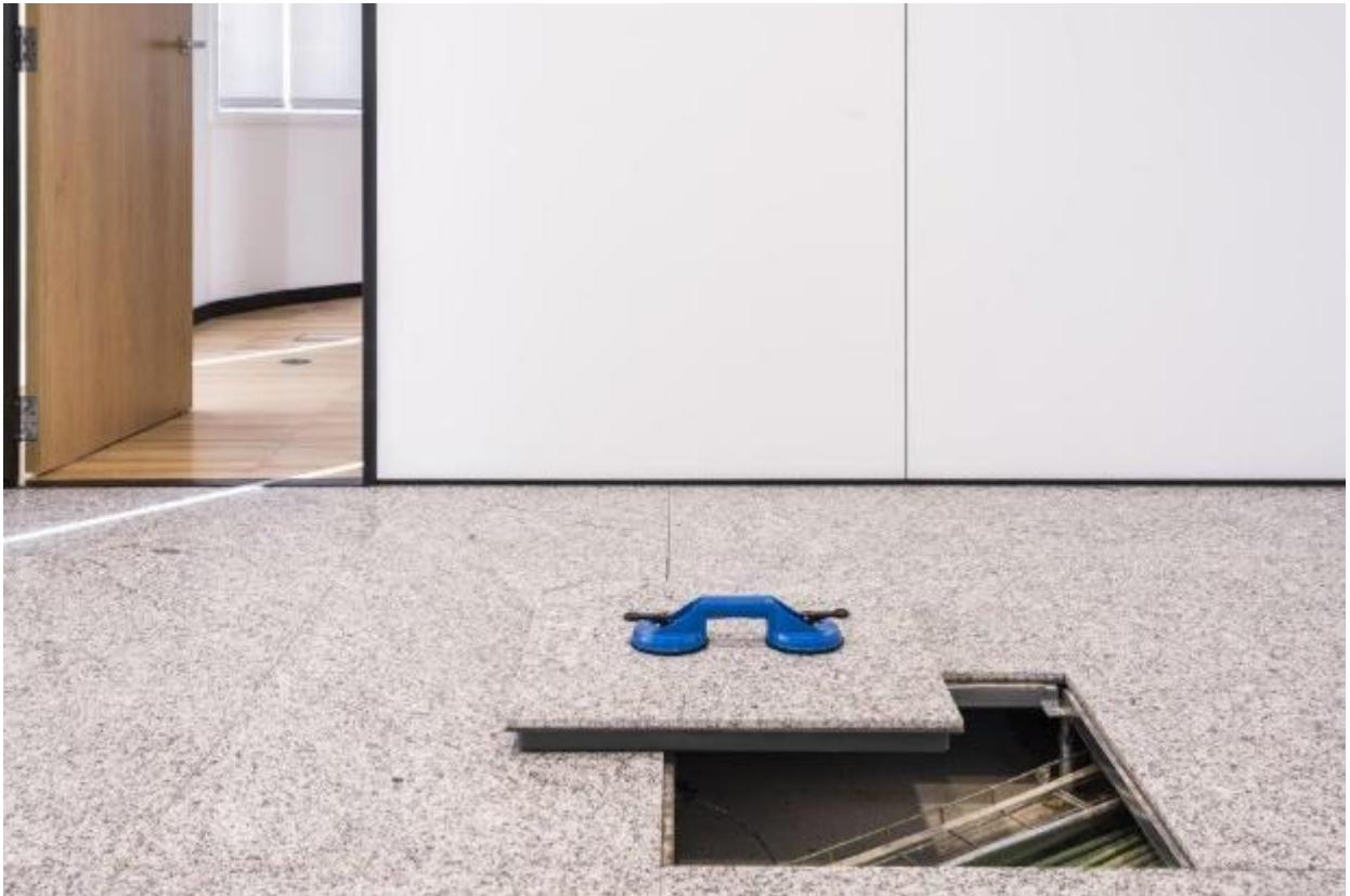
(Detalles del suelo registrable en oficina con revestimiento de granito. Imágenes POLYGROUP©)
