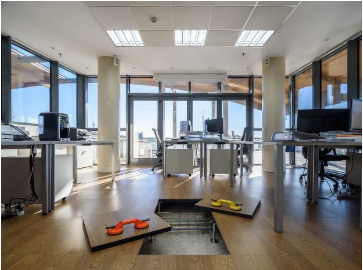
(Suelo técnico elevado POLYGROUP en las oficinas del edificio DTM en Sevilla. Imágenes POLYGROUP©)
