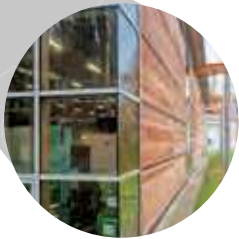
Fábrica de fittings de acero inoxidable NiroSan® en Schmiedefeld, cerca de Dresde, Alemania
