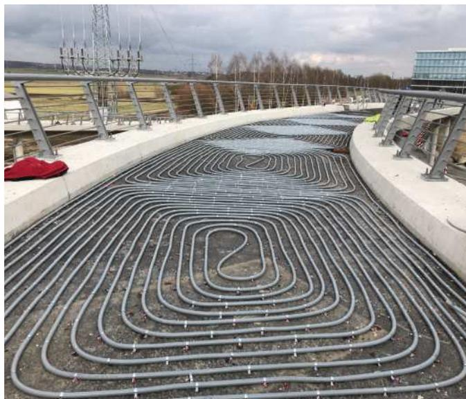
Los sistemas de climatización industrial de REHAU son eficientes incluso en grandes naves y espacios. Los tubos de PE-Xa están alojados, libres de mantenimiento, en la losa de hormigón y ofrecen una gran libertad en cuanto a la utilización de la superficie. La alta proporción de radiación y el bajo perfil térmico garantizan favorables gastos de explotación. Asimismo, las bajas temperaturas de impulsión permiten la utilización de energías alternativas y/o el aprovechamiento de calor residual.
